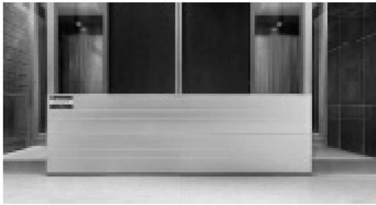
図-1.5 出入口に防水堤を設置した例
